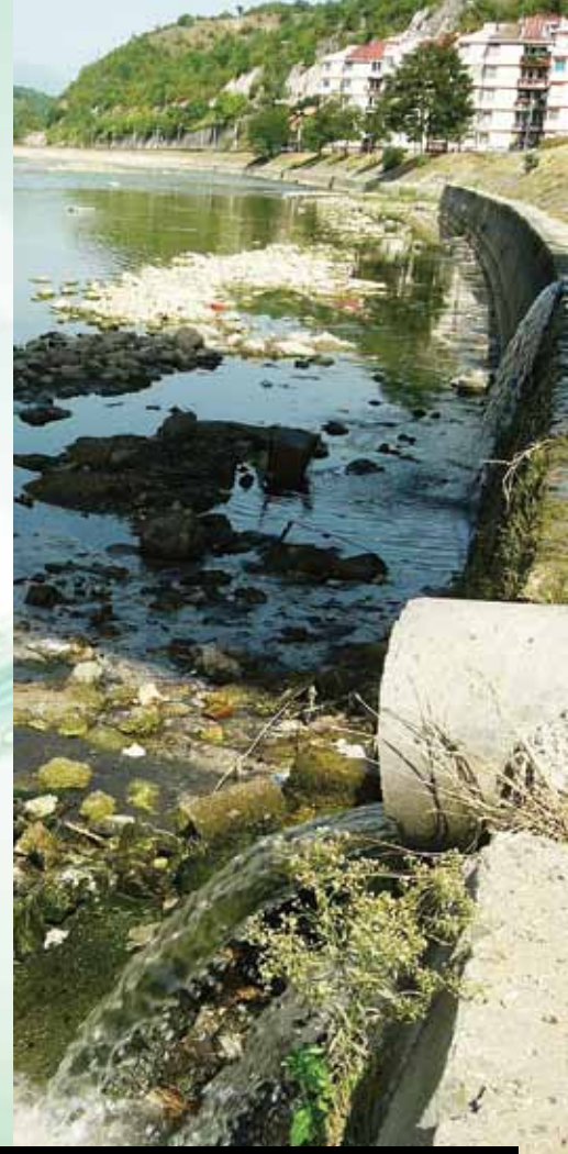
Ispust fekalnih otpadnih voda u Neretvu
